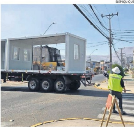
LA FAENA GENERARÁ CORTES DE TRÁNSITO EN AMBAS COMUNAS.
