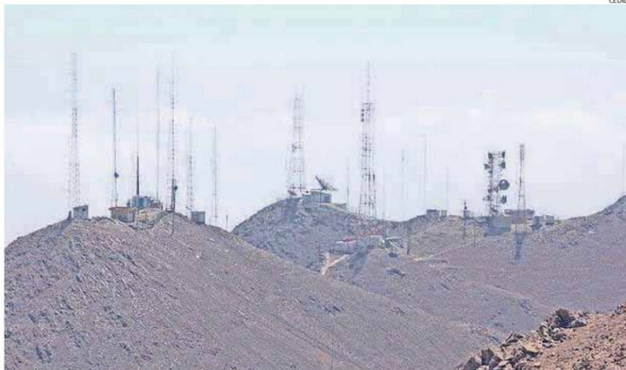
EN CERRO LOS MORROS OPERAN LA MAYORÍA DE LAS ANTENAS DE TRANSMISIÓN.
