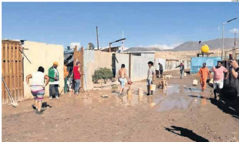
ASÍ AMANECIÓ EL SECTOR DE QUETENA AL PONIENTE DE CALAMA TRAS LAS ÚLTIMAS LLUVIAS QUE AFECTÓ, AL MENOS, A 50 PERSONAS DEL LUGAR.
