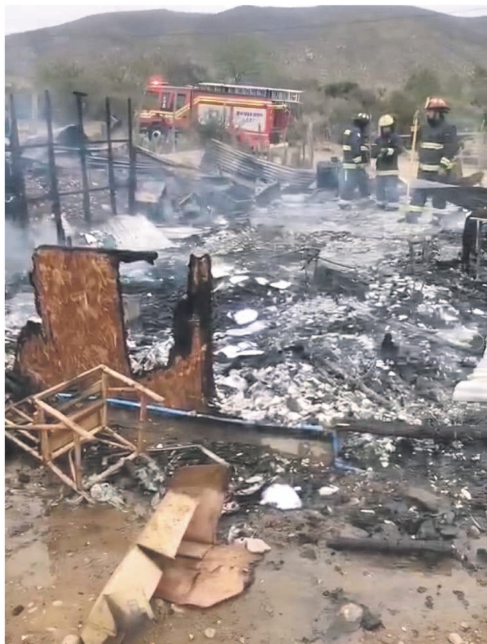
El incendio en Salala se suma a los ocho siniestros estructurales registrados en la comuna en lo que va de 2026.
