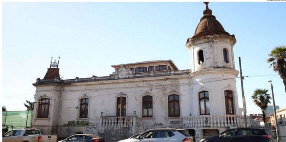
EL INMUEBLE TIENE MÁS DE 100 AÑOS Y ESTÁ CONSTRUÍDO EN HORMIGÓN. ES UNA JOYA QUE LUCE MUY DESMEJORADA Y NECESITA URGENTE MANTENCIÓN.
