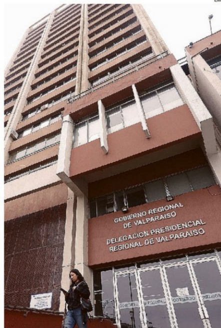
EDIFICIO ESMERALDA HOY ESTÁ PRÁCTICAMENTE DESOCUPADO.
