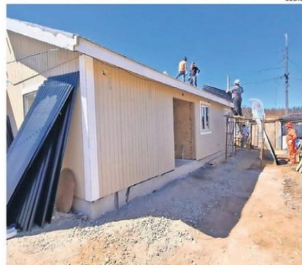
INSTALACIÓN DE VIVIENDAS INDUSTRIALIZADAS POR EL GOBIERNO.
