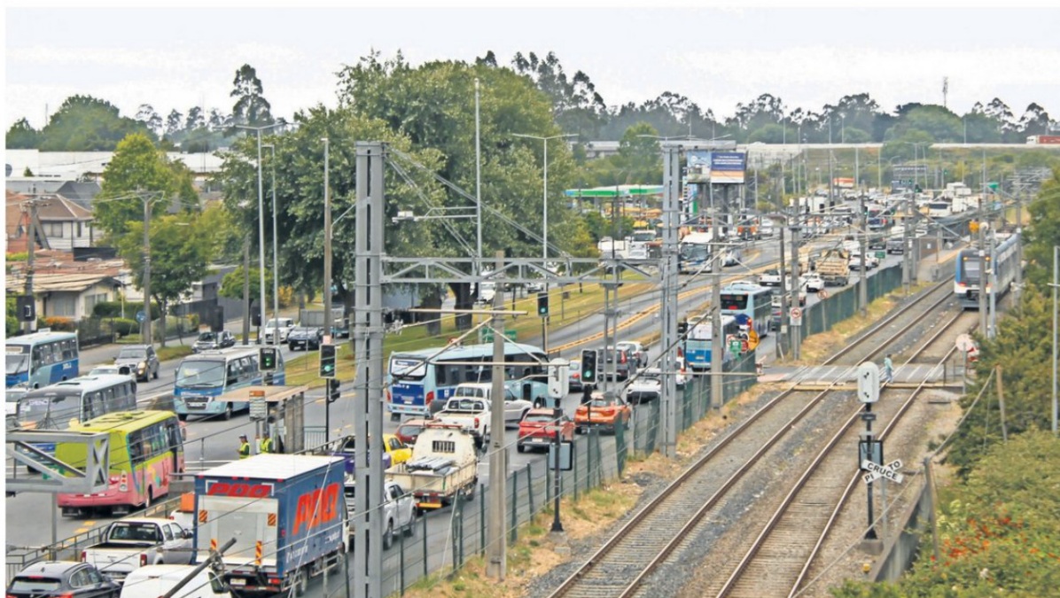
Uno de los puntos más críticos es la avenida Pedro Aguirre Cerda de San Pedro de la Paz, considerando las faenas del Puente Industrial.
