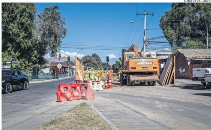
OBRA EN CALLES LOS CARRERA, SEGÚN SEREMI DE TRANSPORTE, DEBERÍAN ESTAR TERMINADAS INICIOS DE MARZO.
