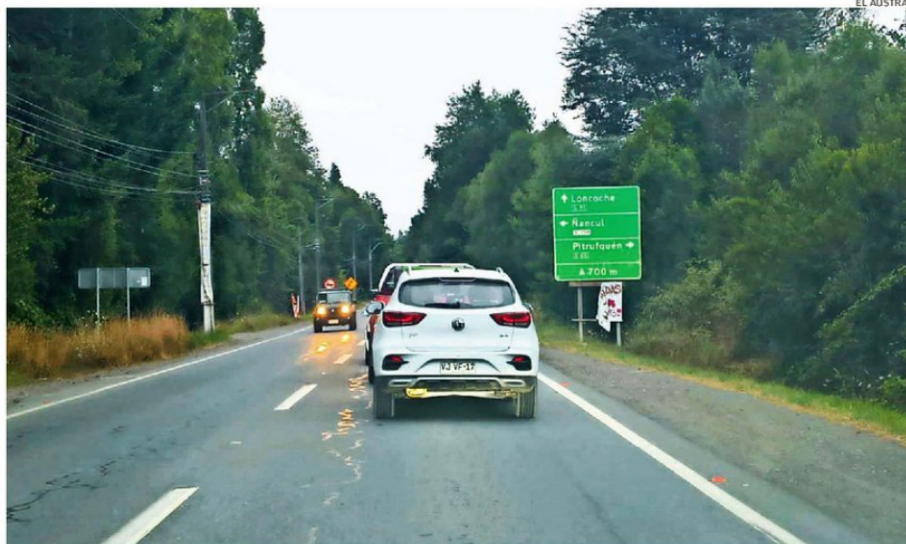
EL CAMINO VILLARRICA-LONCOCHE POR ÑANCUL EMPIEZA A ASOMAR COMO UNA ALTERNATIVA PARA LA INTERVENCIÓN DE DOBLE VÍA.
