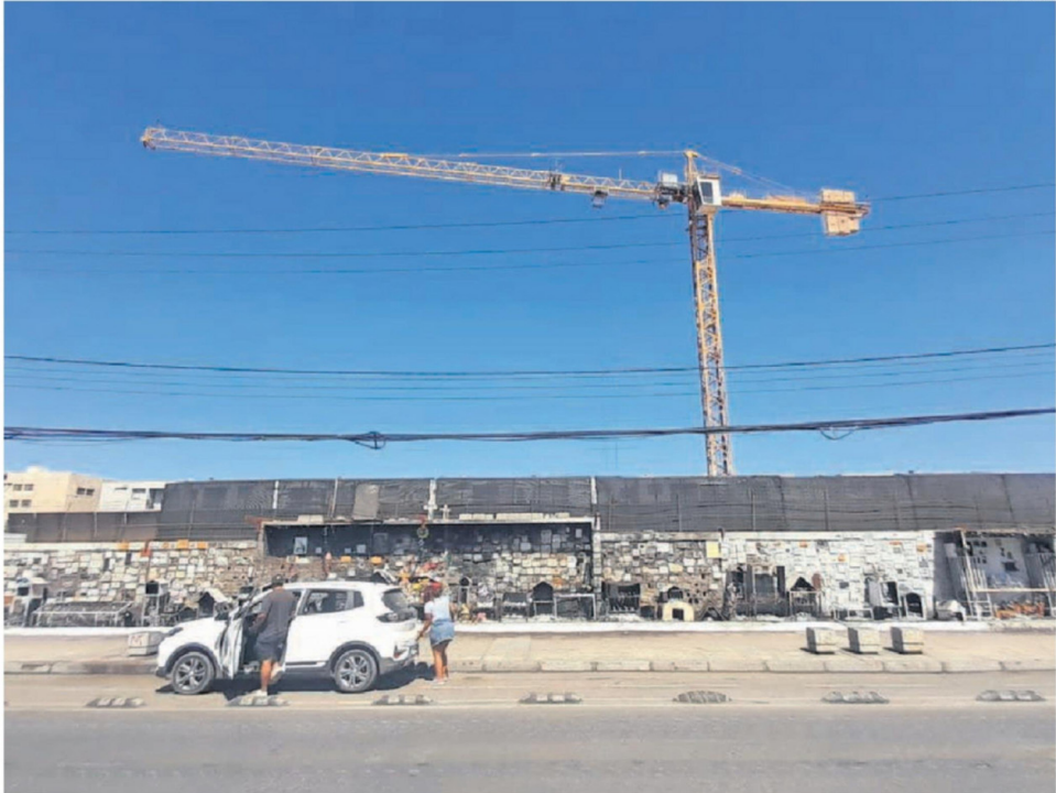
A FINES DEL AÑO 2025 COMENZARON LAS OBRAS EN EL LUGAR PARA CONSTRUIR UN COMPLEJO HABITACIONAL.
