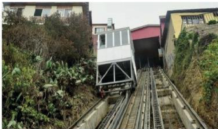
Inaugurado en 1911, el ascensor Espiritu Santo une las calles Rudolph (estación superior) y Aldunate (estación inferior)
