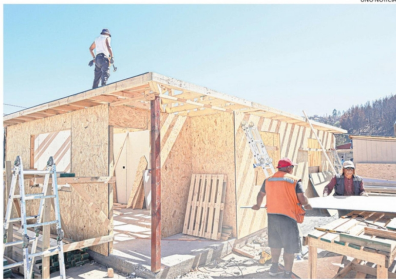
RECONSTRUCCIÓN DE VIVIENDA EN EL SECTOR GABRIELA MISTRAL DE LIRQUÉN, COMUNA DE PENCO.
