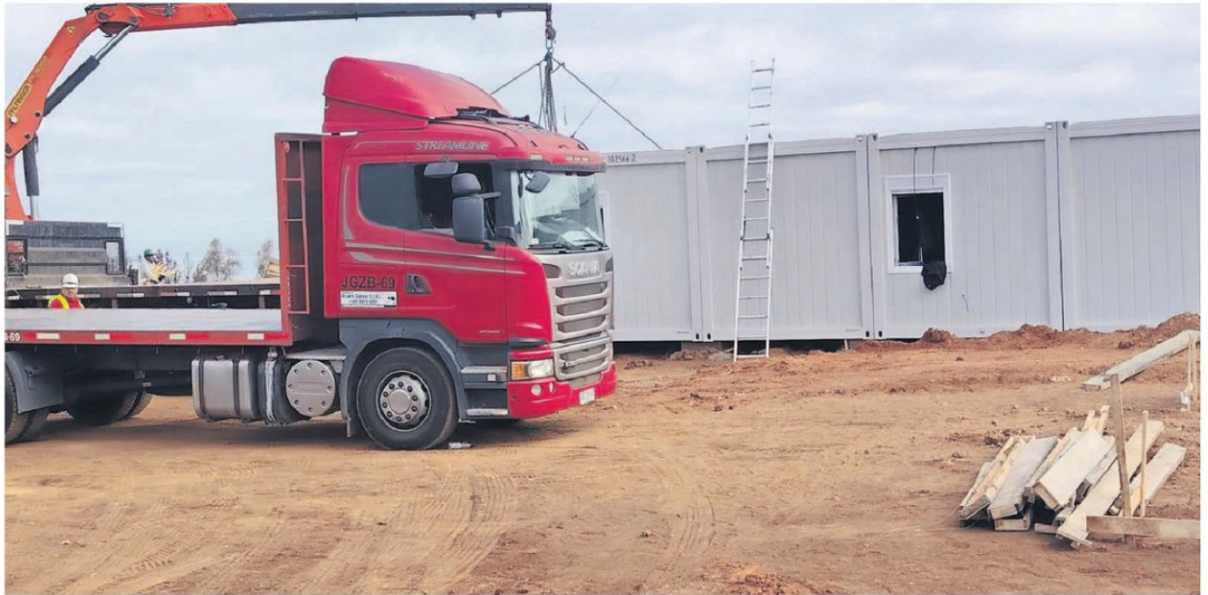
Equipos trabajaron el miércoles en la instalación de las enfierraduras para la estructura principal del establecimiento.
