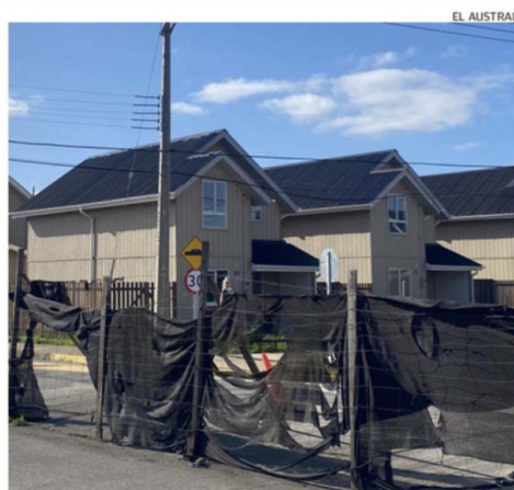
ACTUALMENTE SE CONSTRUYEN VARIOS PROYECTOS EN LA COMUNA.
