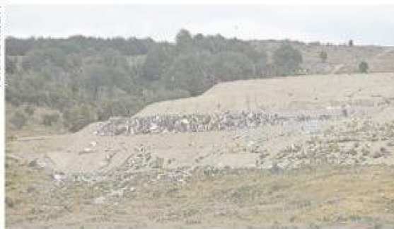
El vertedero municipal deberá operar bajo un plan de readecuación para extender su vida útil hasta 2029, mientras se concreta la construcción del nuevo relleno sanitario.
