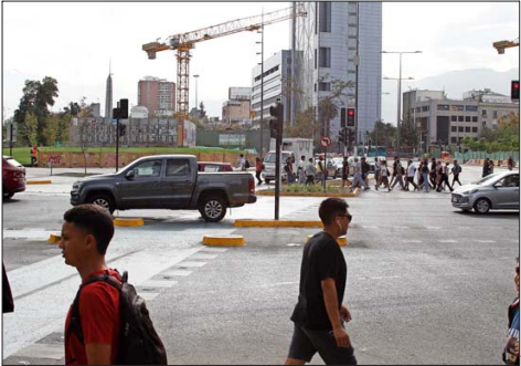
OBRAS.— El proyecto de Nueva Alameda-Providencia ha levantado quejas de automovilistas por cambios en flujos y la disposición de virajes.
