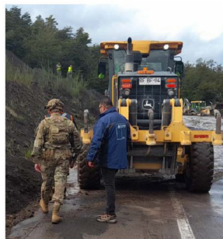
CON MÁQUINAS SE TRABAJA EN EL SECTOR PARA EL DESPEJE DE LA RUTA. DELEGADA DESTACÓ TRABAJO DE VIALIDAD.
