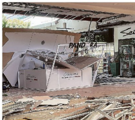
COLAPSO SE PRODUJO EN EL CENTRO COMERCIAL PORTAL EL BELLOTO.
