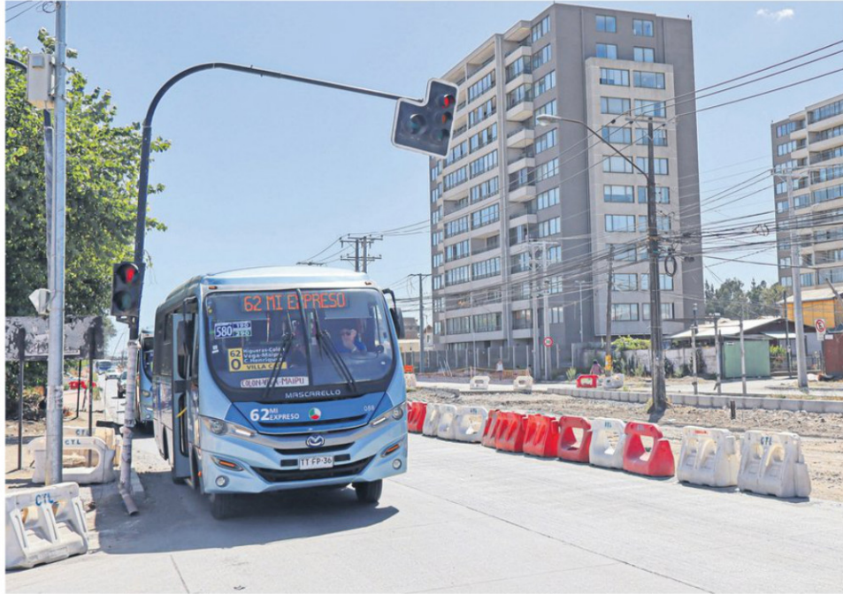
Uno de los puntos de preocupación de las autoridades tiene relación con las obras del Eje Colón, donde se pidió a Serviu instalar señalética.
