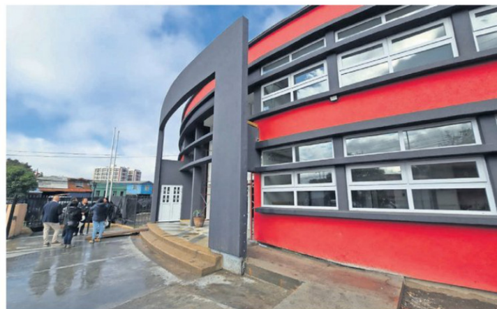
Entre las obras del colegio Rebeca Matte se considera la renovación de la fachada.
