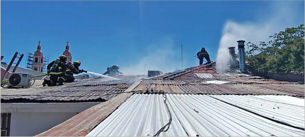
Una falla eléctrica sería las hipótesis del origen de la situación.
