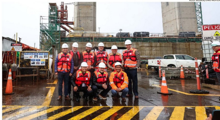
BAJO UNA INTENSA LLUVIA LOS GOBERNADORES REGIONALES VISITARON LAS FAENAS DEL PUENTE CHACAO.
