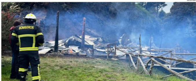
BOMBEROS SOLO PUDO REMOVER ESCOMBROS POR LO COMPLEJO DEL ACCESO EN DUHATAO. CEDIDA
