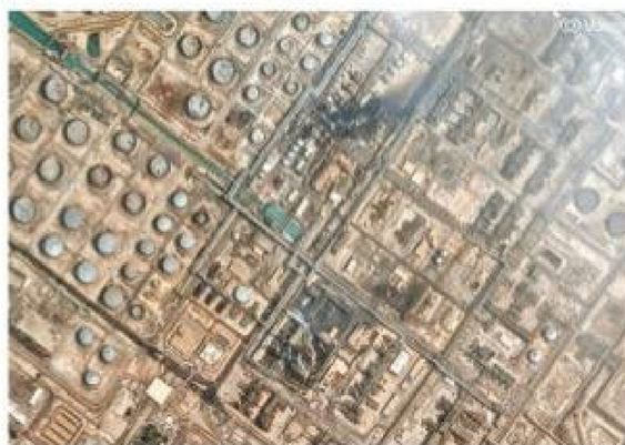
Esta imagen de satélite muestra una visión general de los daños después de un ataque con drones a la refinería de petróleo Ras Tanura, en Arabia Saudita.
