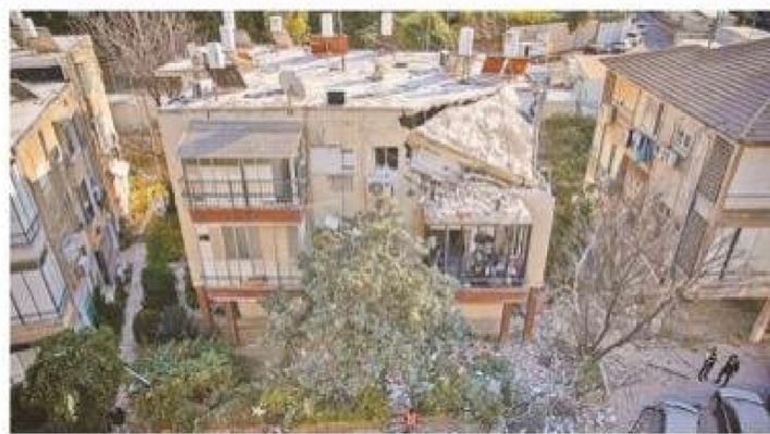
Los oficiales del Comando del Frente Interior de Israel inspeccionan un edificio de apartamentos dañado después de un ataque con misiles iraníes.
