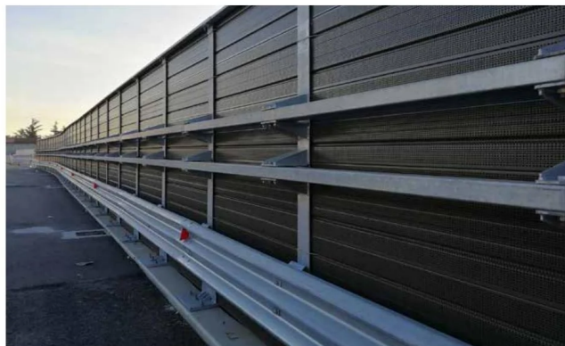
Barrera acústica integrada en autopista Milano-Genova, Italia.
