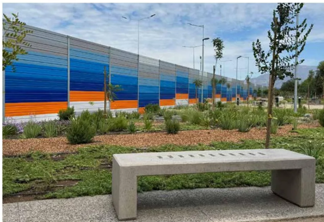
Barrera acústica absorbente Parque Serrano, Pudahuel.
