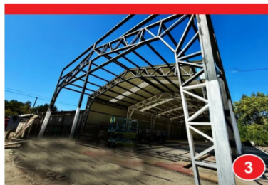
Avanzan obras de moderno terminal de buses para Chanco
