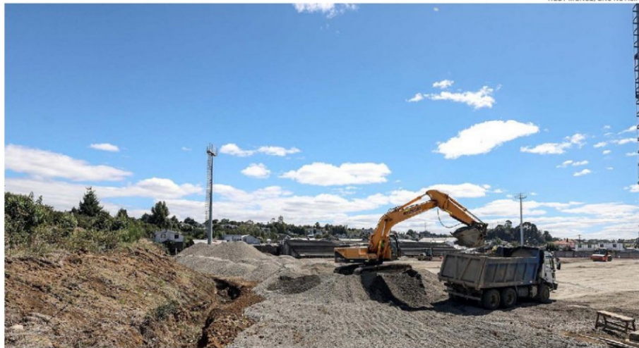
LA NIVELACIÓN DEL TERRENO MARCA EL FIN DE 15 AÑOS DE ESPERA. AUTORIDADES DESTACAN QUE EL PROYECTO SEPULTA UNA ETAPA DE "REZAGO".
