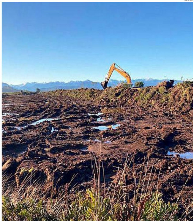
CON MAQUINARIA PESADA SE INTERVIENE EL CAUCE, LO QUE DERIVÓ EN EL ANEGAMIENTO A OTROS SECTORES.
