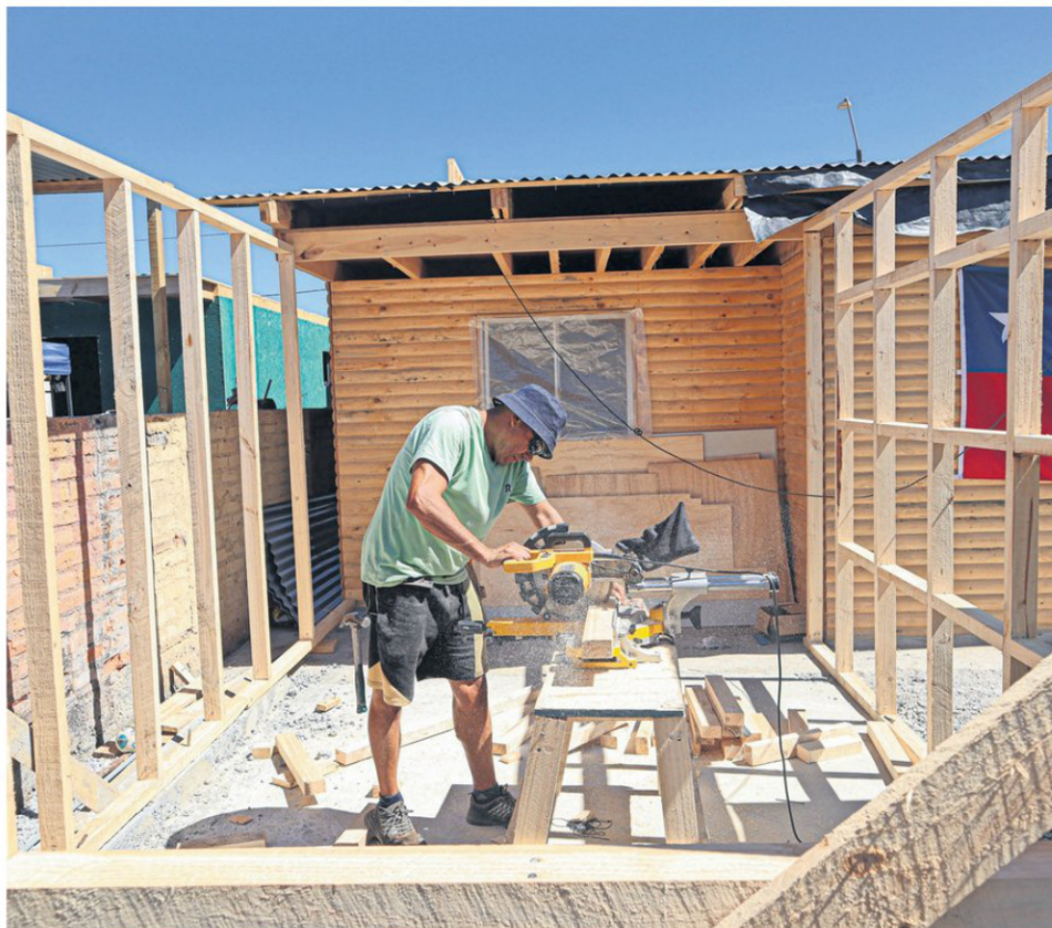
A 47 días de iniciados los incendios forestales, varias familias trabajan en la autoconstrucción de sus inmuebles.
