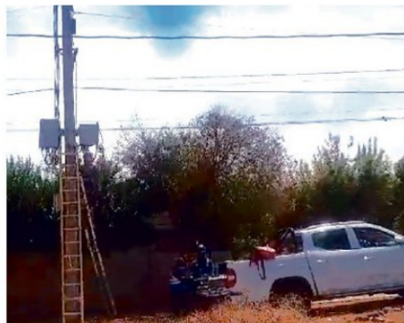
A COMIENZOS DE FEBRERO INSTALARON LOS DISPOSITIVOS.
