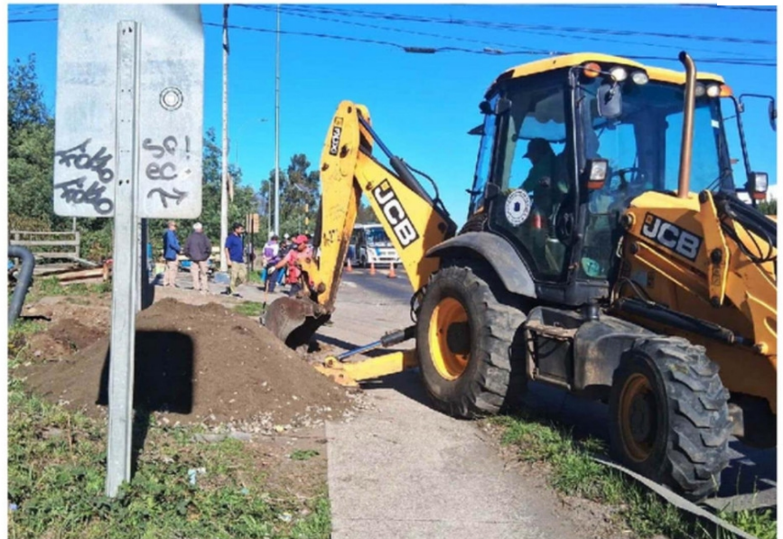
A LAS 10 HORAS DE AYER SE DIO INICIO AL TRABAJO DE MAQUINARIA PESADA PARA EL CIERRE DEL PUENTE.
