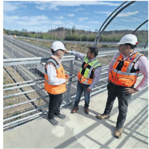
Autoridades fiscalizaron el inicio de las faenas en la ruta que conectará con el nuevo enlace a Florida.
