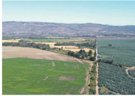
Proyecto Eólico Fénix busca instalar 16 aerogeneradores.
