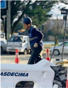
n nuevo programa de renovación de re- ión aproximada de $155 millones.La pri- n de redes en calle Italia, desde Avenida lle García Reyes, entre Carlos Anwandter Prensa Aguas Décima
