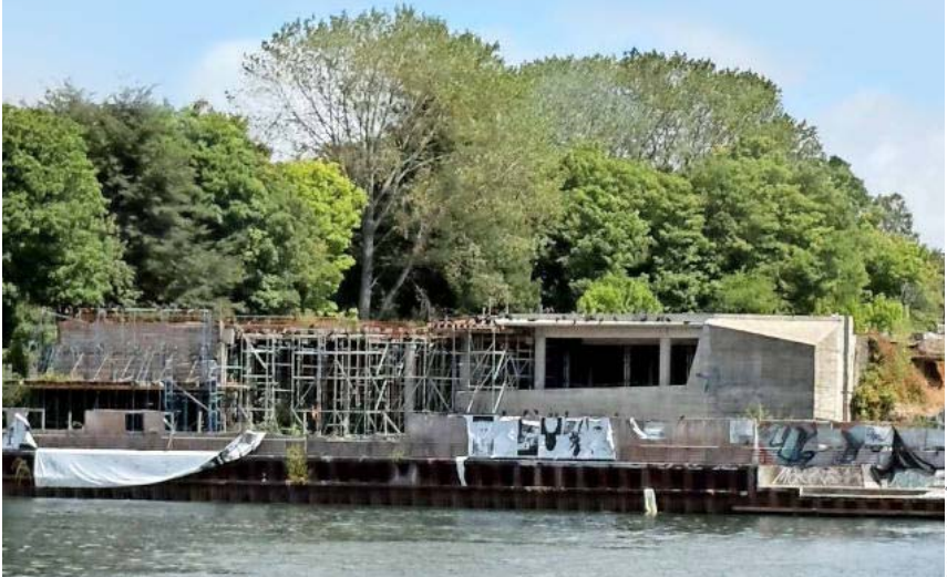
Obras paralizadas MAC Valdivia, febrero 2026.
