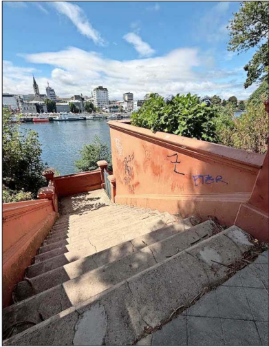
Escalera hacia el embarcadero Casa Anwandter.
