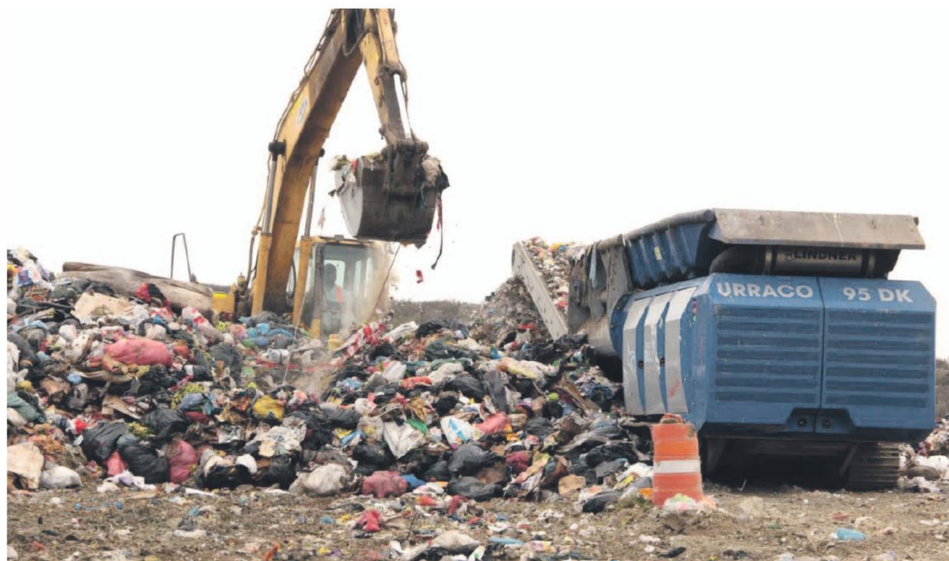
El relleno sanitario El Panul concentra más de la mitad de los residuos domiciliarios generados en la Región de Coquimbo.
