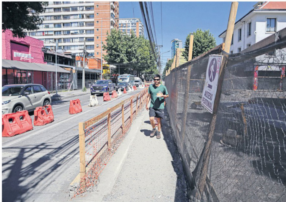
La obra contempla una prórroga de 71 días desde el 18 de febrero, por lo cual se estima que será entregada en mayo.
