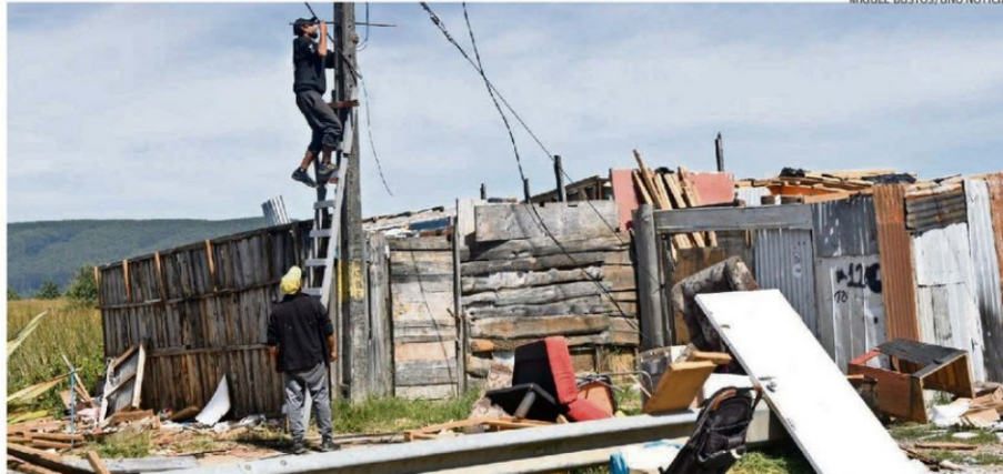
DURANTE LA SEMANA SE LOGRÓ EL CIENTO POR CIENTO DEL DESARME DE LAS VIVIENDAS QUE QUEDABA EN EL CAMPAMENTO LAS MULATAS.
