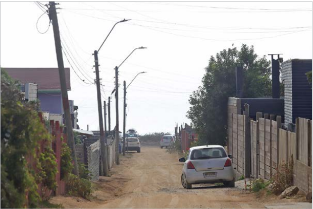
La construcción indiscriminada de viviendas sin la debida permisología colapsa los servicios básicos en verano y pone en riesgo la seguridad de la ciudadanía.
