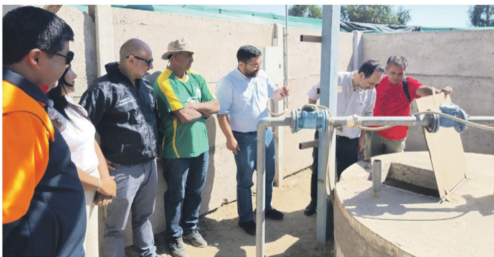
Los proyectos consideran la habilitación de pozos y la instalación de arranques domiciliarios para mejorar el acceso al agua en sectores rurales de la Región de Coquimbo.
