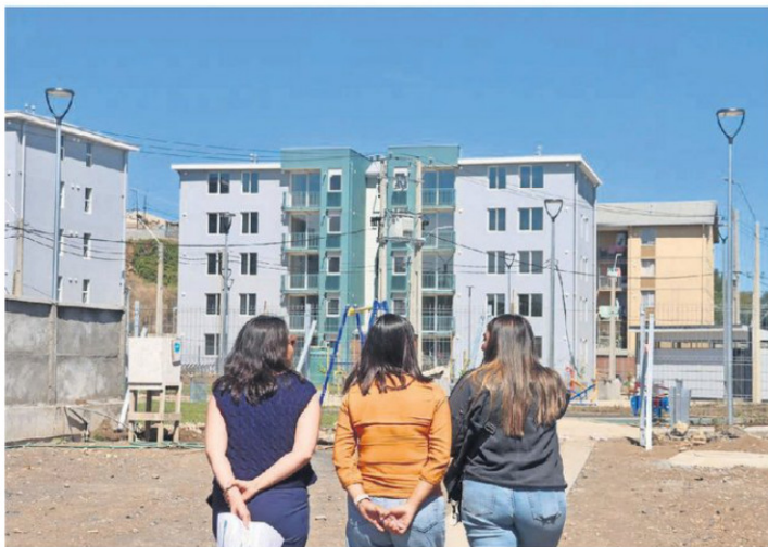
Las obras contemplan una sede social, áreas verdes y ventanas termopanel.
