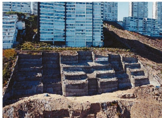
LA EDIFICACIÓN EN EL SECTOR DE COCHOA ESTÁ PARALIZADA.
