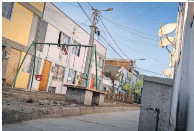
48 VIVIENDAS TENÍAN PROBLEMAS DE FUGA DE AGUA.
