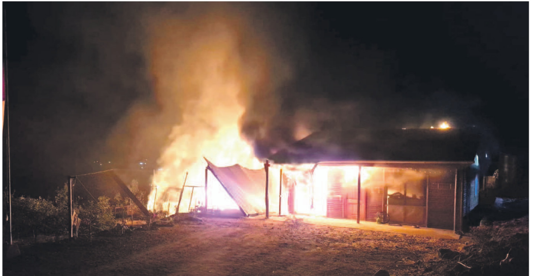
El siniestro provocó daños cercanos al 80% en la vivienda, cuya terraza resultó completamente destruida.
