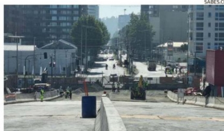
El viaducto ya está conectado a avenida Chacabuco.
