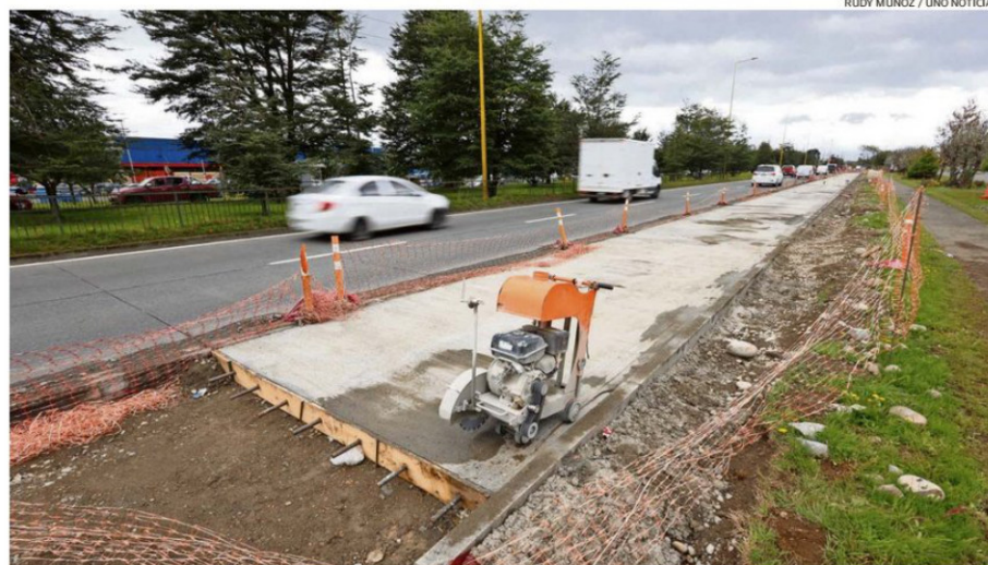
LOS TRABAJOS QUE SE REALIZAN EN EL ACCESO SUR DE PUERTO MONTT BUSCAN AGILIZAR EL FLUJO VEHICULAR DESDE Y HACIA LA RUTA 5.
