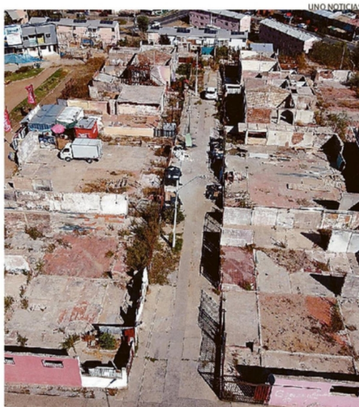
UNO DE LOS DESAFÍOS ES LA RECONSTRUCCIÓN PENDIENTE EN VIÑA.
