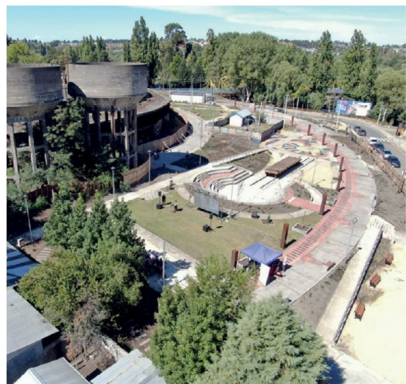
LA OBRA TRANSFORMA un espacio abandonado en el nuevo corazón comunitario de San Rosendo.
