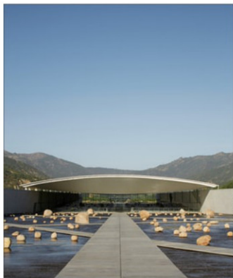
La viña VIK tiene un único techo de lona transparente que permite que la luz natural penetre la bodega.
